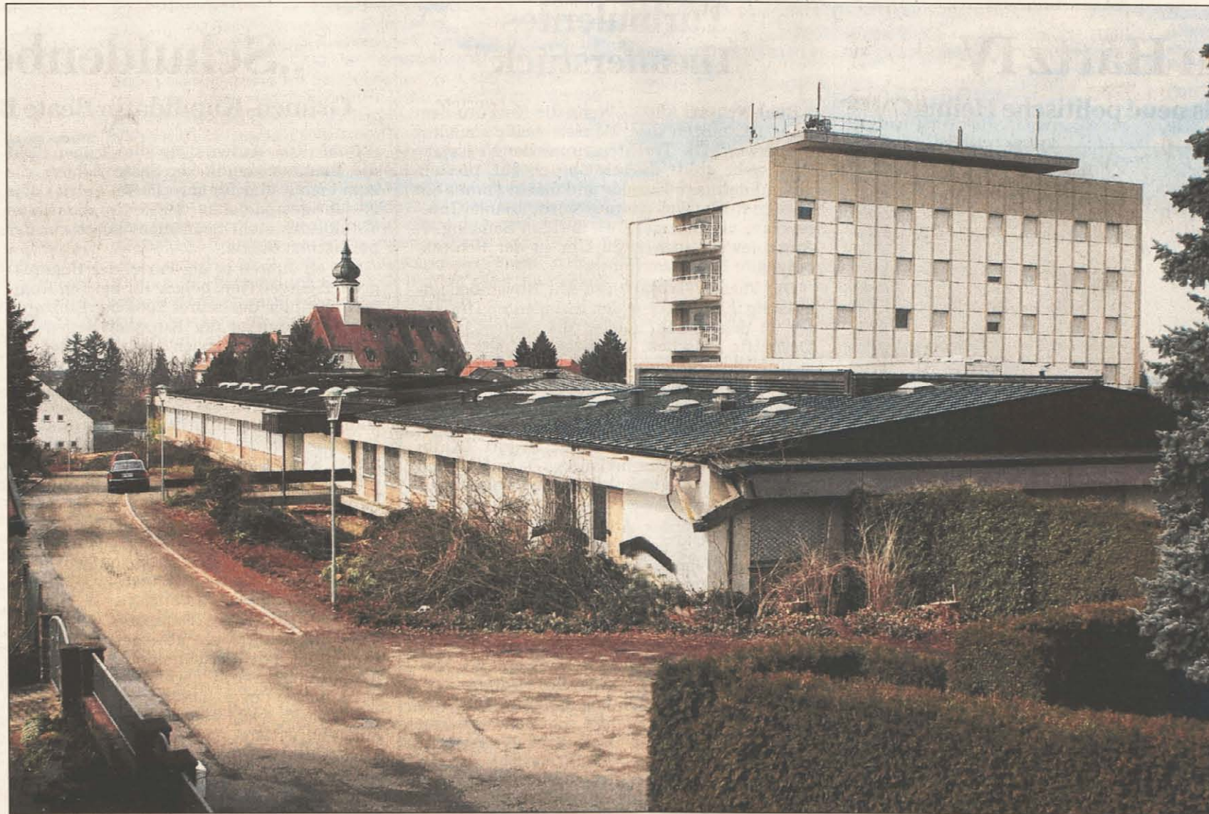
ABGERISSEN wird die sechsgeschossige St.-Hedwig-Schule samt angrenzender Halle. Auf dem Gelände will ein privater Investor 20 Baugrundstücke erschließen. Der Gemeinderat gab grünes Licht für die Aufstellung des vorhabenbezogenen Bebauungsplanes „Sonnhalde“. Foto: Bernhard Margull
